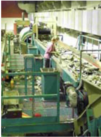
Figura 11. Cinta de transportación para clasificación y separación.
