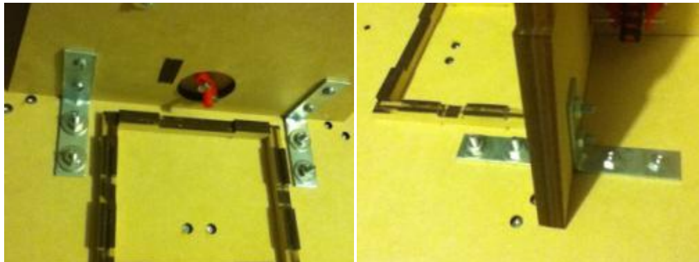
Figuras 3.52 y 3.53. Imágenes de la instalación de un poste sobre la base móvil.
