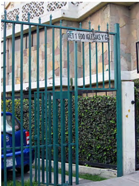
Figura 345. Puerta de acceso peatonal hacia el retorno donde se ubica el lugar de los hechos
