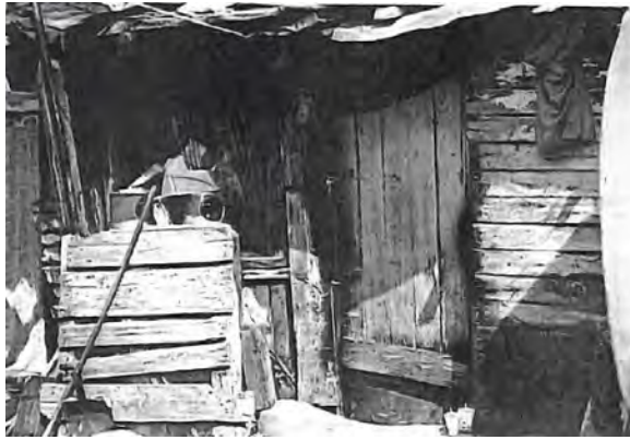
Figura 366. Se observa la fachada de una vivienda construida de madera
