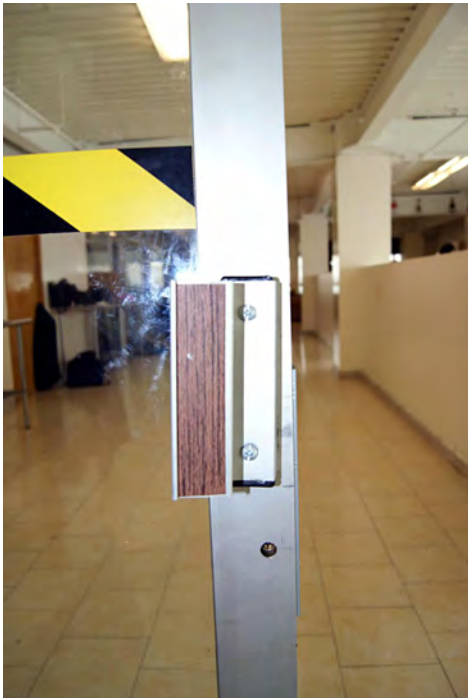
Figura 380. Acercamiento a la manija que abre la puerta principal
