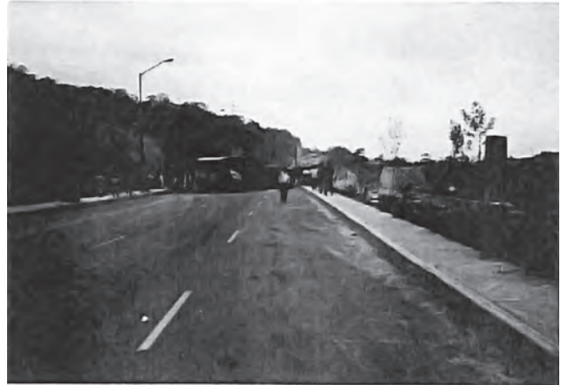
Figura 314. Se observa un arroyo de circulación de 12 metros de ancho, con banquetas en ambos lados de 3 metros, con circulación de sur a norte y viceversa a nivel plano y sin obstáculos, con campos visuales amplios, ya que la topografía del mismo lo presenta en línea recta. En dicho arroyo se aprecian, en el kilómetro 13+300, dos vehículos, uno de la ruta 100 del servicio público y un camión tipo volteo del servicio público federal.
