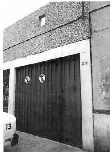
Figura 356. Fachada que da acceso a la vivienda
