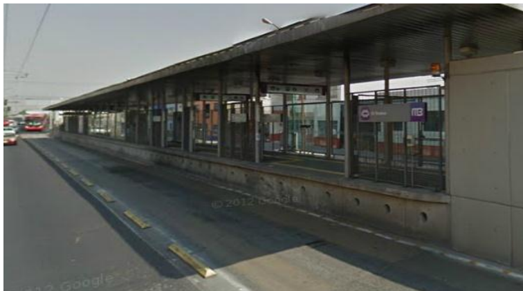
Ilustración 167 Línea 2 del Metrobús, estación sin paradas secundarias
