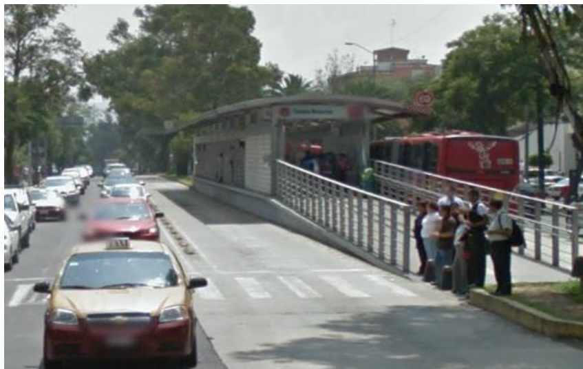
Ilustración 112 Línea 1 del Metrobús, estación sin paradas secundarias
