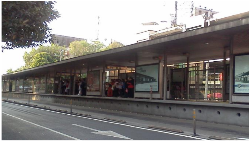
Ilustración 160 Sin carril de rebase en estación Línea 2, Metrobús
