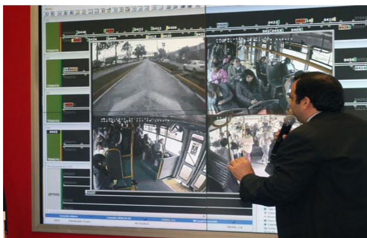
Ilustración 203 Centro de control Metrobús
