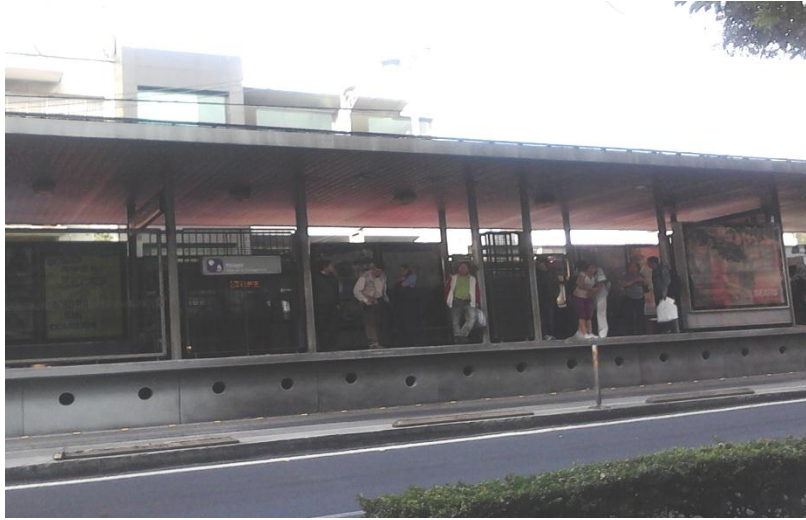
Ilustración 168 Metrobús no cuenta con puertas corredizas en las estaciones
