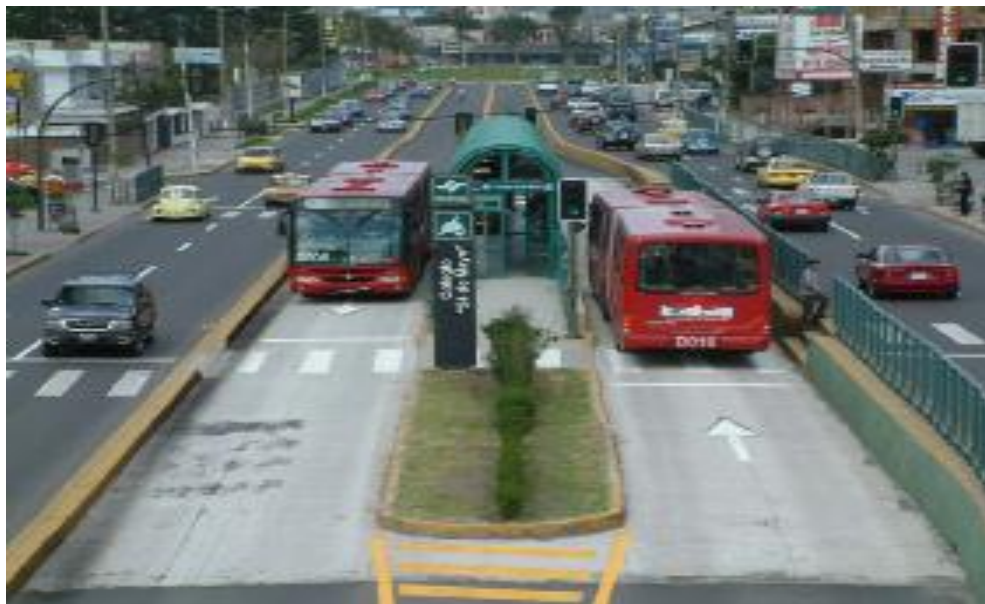
Ilustración 64 Estación en plataforma central Quito, Ecuador.
