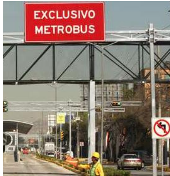
Ilustración 198 Señalamiento que prohíbe vuelta a la izquierda a través del carril del Metrobús
