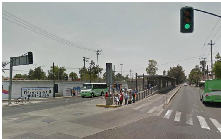
Ilustración 162 Estación Leyes de Reforma, Línea 2
