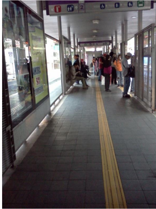
Ilustración 193 Estación de la Línea 2 con buen mantenimiento
