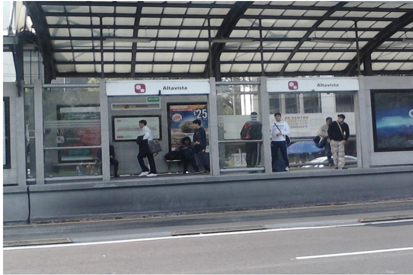
Ilustración 114 Metrobús no cuenta con puertas corredizas en las estaciones
