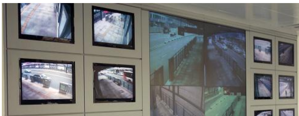
Ilustración 58 Centro de control BRT en Cantón, China.
