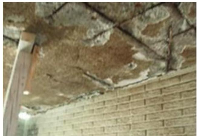
*Figura 3.41 Daño en acabados de muro y desprendimiento del recubrimiento en losa*
