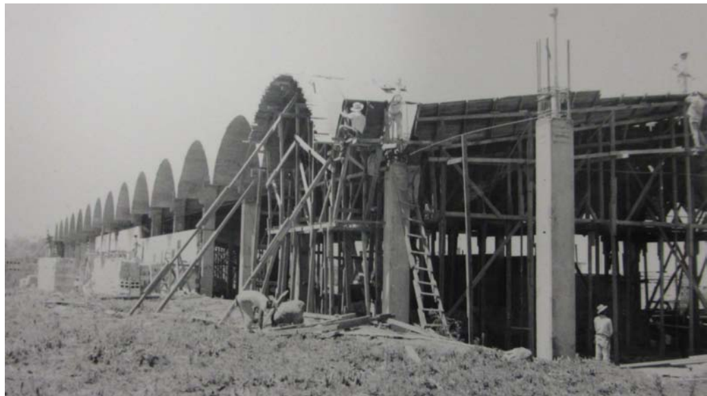
Fig. 57 Proceso constructivo y detalle del encofrado de las bóvedas corridas. Archivo Max Cetto, UAM-A
