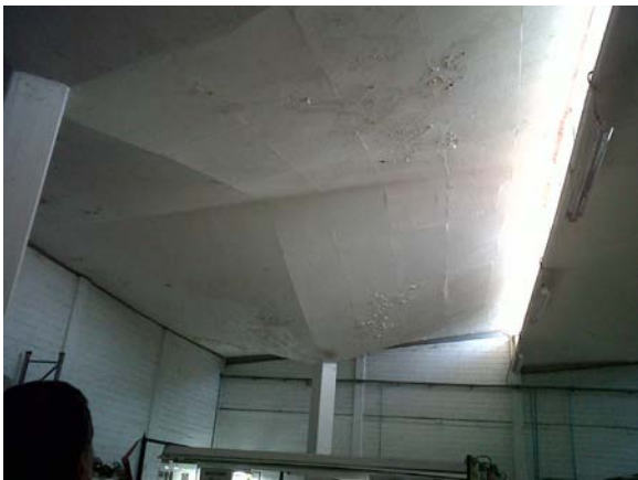
Fig. 93 Interior del área de bodegas, se observan los paraguas dañados que componen el edificio, 2012. Fotografía: Luis Manuel Chacón
