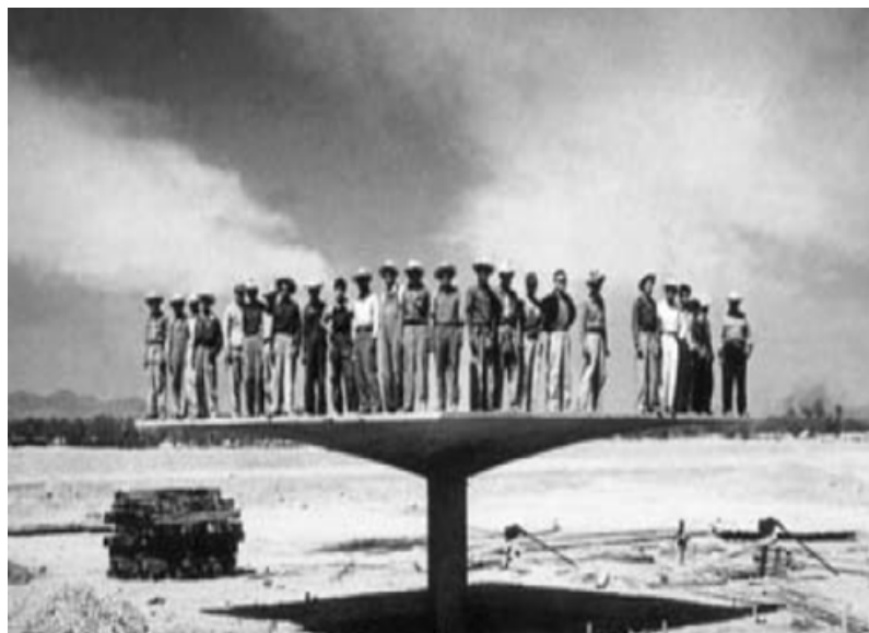
Fig. 75 Paraguas experimental. Félix Candela (1953)
