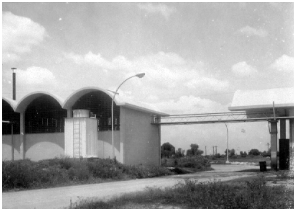
Fig. 54 Vista posterior de la casa de máquinas. Archivo Max Cetto, UAM-A
