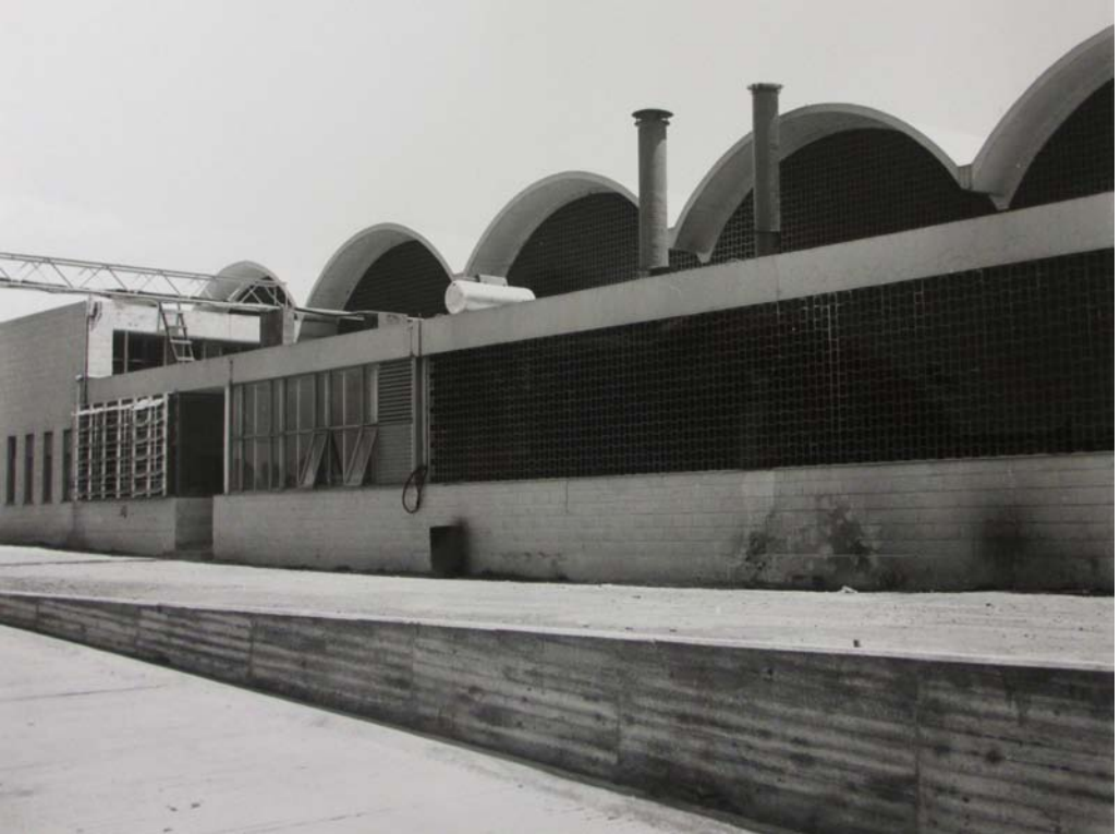
Fig. 49 Fachada original de la nave principal. Archivo Max Cetto, UAM-A
