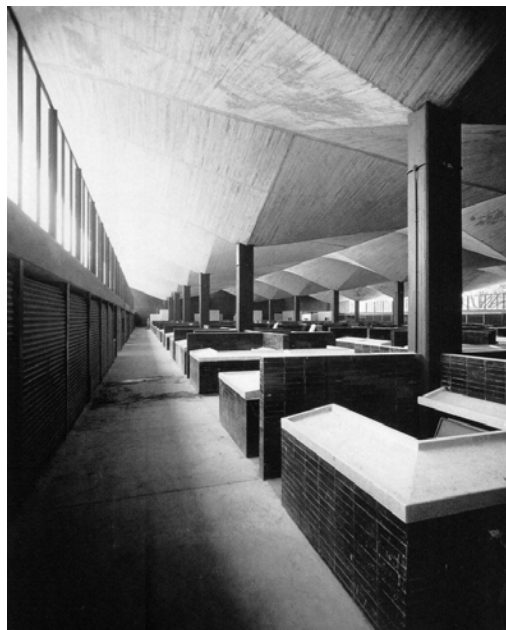
Fig. 25 Mercado de Coyoacán, D.F., 1956. Arquitectos: Pedro Ramírez Vázquez y Rafael Mijares. Construcción: Félix Candela (pp 120).
