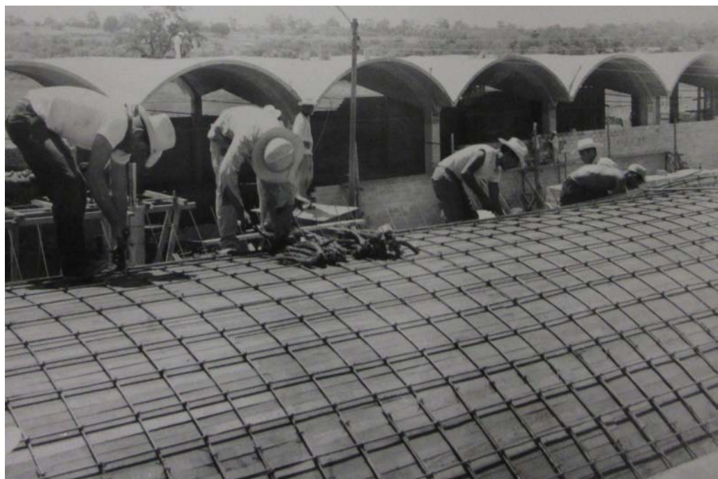
Fig. 58 Detalle del amarre de las varillas para las bóvedas corridas. Archivo Max Cetto, UAM-A
