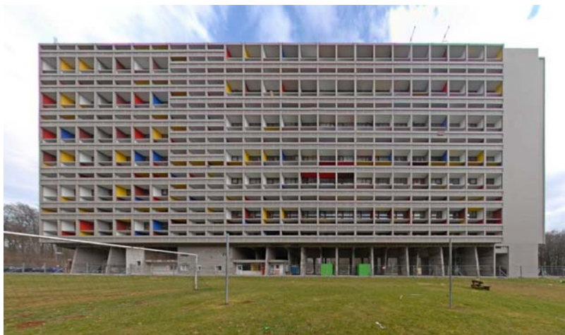
Fig. 2 Unité D'Habitation Marseille. Le Corbusier. Francia (1947)
