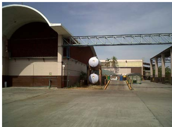
Fig. 88 Estado actual de la fachada de la nave principal, 2012. Fotografía: Luis Manuel Chacón
