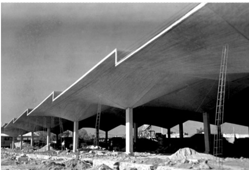
Fig. 30 Almacenes con cubiertas de paraguas.
