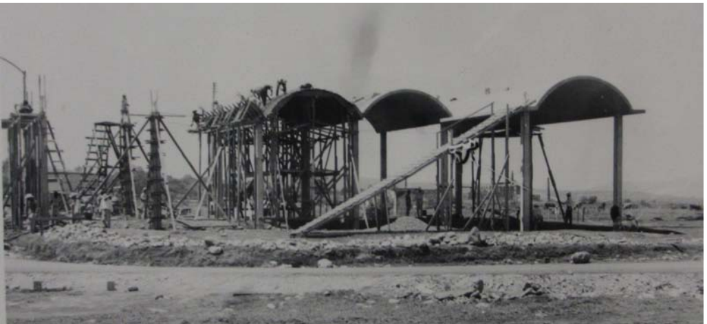
Fig. 56 Detalle de cimbrado y construcción de los conoides en la nave principal. Archivo Max Cetto, UAM-A
