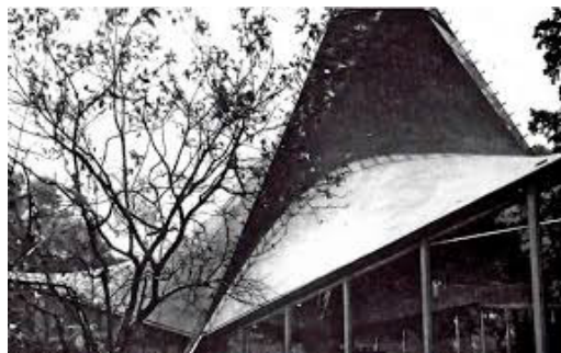
Fig. 32 Capilla de San Vicente en Coyoacán, D.F. (Arqtos. Enrique de la Mora y Fernando López Carmo- na).
