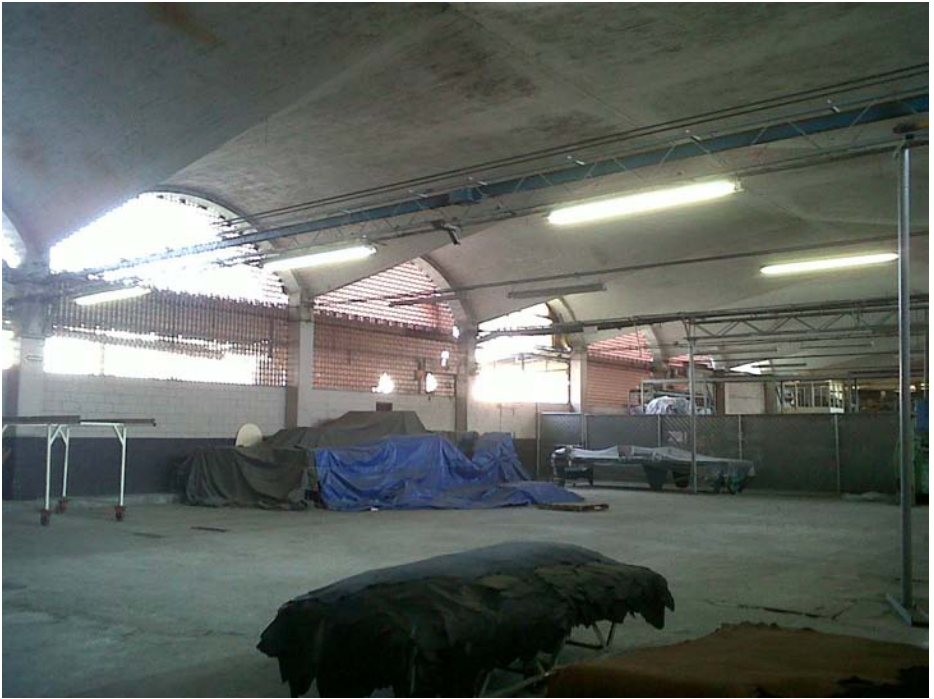
Fig. 85 Estado actual del interior de la nave (2012). Fotografía: Luis Manuel Chacón
