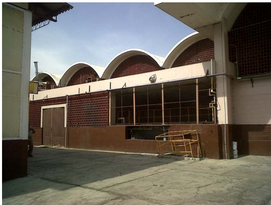
Fig. 84 Estado actual de la fachada de la nave (2012). Fotografía: Luis Manuel Chacón
