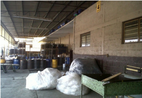
Fig. 91 Estado actual de la fachada del área de bodegas, modificada, 2012. Fotografía Luis Manuel Chacón
