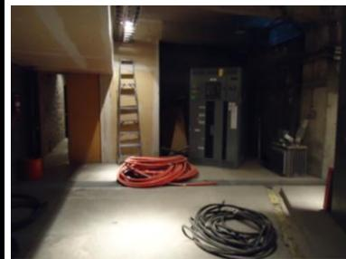
Esta subestación cuenta con un transformador tipo pedestal de 750 [kVA], el cual se encuentra en el exterior del inmueble. El gabinete y los tableros de distribución se localizan en el sótano de la dependencia. La subestación es utilizada como bodega.
