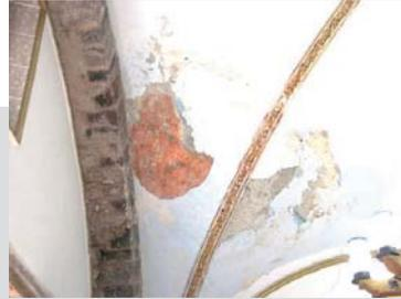
157. Bóveda de cañón con daño por filtración, desprendimiento de aplanados
