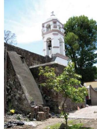
FACHADA LATERAL NORTE, CONTRAFUERTE Y MURO ESCALINATAS EN PIEDRA BRASA, TORRE CAMPANARIO, CONTRAFUERTE CON DESPLOME.
