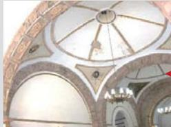
156. Cúpula con daño estructural. Filtraciones y desprendimiento de aplanados.
