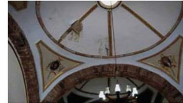
CÚPULA SEGUNDA CRUJÍA DE LA NAVE PRINCIPAL DE ASAMBLEA. PRESENTA DETERIORO EN LOS APLANADOS CON DESPRENDIMIENTOS, PROVOCADOS POR EL DESPLOME DEL MURO DE CARGA AL NORTE DE LA NAVE, DEBIDO A LOS HUNDIMIENTOS DIFERENCIALES EN ESA SECCIÓN, ENTRE LOS EJES CONSTRUCTIVOS 7-9.
