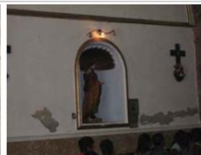
MURO INTERCUPULAR NORTE DE LA NAVE PRINCIPAL DE ASAMBLEA. PRESENTA DESPLOME POR HUNDIMIENTOS DIFERENCIALES. MURO DE PIEDRA BRASA VOLCÁNICA QUE EN EXTERIOR TIENE AUSENCIA DE APLANADOS Y AL INTERIOR PRESENTA APLANADOS A BASE DE ARENA-CEMENTO, ASÍ COMO RODAPIÉ A BASE DE LOSETA CERÁMICA AL IGUAL QUE LA EXISTENTE EN PISOS. SE OBSERVAN DETERIORO POR DESPRENDIMIENTO DE APLANADOS Y PROBABLE FRACTURA EN SENTIDO HORIZONTAL EN EL TERCIO BAJO POR ENCIMA DE RODAPIÉ.
