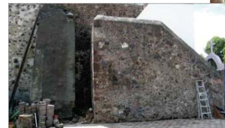
MURO Y CONTRAFUERTE EN PIEDRA BRASA CON RAJUELEADO Y LAJAS. CONTRAFUERTE CON APLANADOS EN CEMENTO ARENA EN LA PARTE SUPERIOR, REMATADO IRREGULARMENTE EN EL EMPOTRAMIENTO SUPERIOR.
