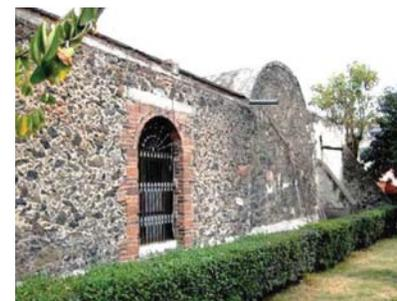
VANO RECTANGULAR CON ARCOS DE MEDIO UNTO Y ENMARCAMIENTO A BASE DE ENLADRILLADOS CON MAMPOSTERÍA. PROTECCIÓN Y VENTANA DE HERRERÍA. REMATE SUPERIOR DE PRETEL CON ENLADRILLADOS IRREGULARES Y DETERIORADOS.
