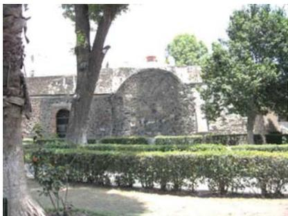
MURO Y CONTRAFUERTE EN PIEDRA BRASA CON RAJUELEADO Y LAJAS. CONTRAFUERTE CON APLANADOS EN CEMENTO ARENA EN LA PARTE SUPERIOR, REMATADO IRREGULARMENTE EN EL EMPOTRAMIENTO SUPERIOR.
