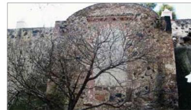
FACHADA ALTAR LATERAL NORTE CON VANO TAPIADO CON TABIQUE-CEMENTO-ARENA. MURO DE PIEDRA BRASA COMBINADO CON LAJAS Y RAJUELIADO.
