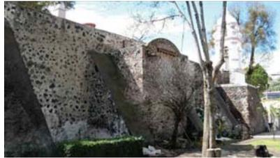
FACHADA ALTAR LATERAL NORTE Y CONTRAFUERTE EN PIEDRA BRASA y RECUBRIMIENTO APLANADOS EN CEMENTO-ARENA.
