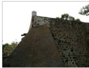
CONTRAFUERTE TRAPEZOIDAL FACHADAS NORTE-ORIENTE Y CONTRAFUERTE PASO DE RONDA EN FACHADA ORIENTE EN PIEDRA BRASA y RECUBRIMIENTO CEMENTO-ARENA.
