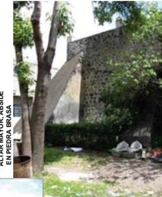
ESQUINA ORIENTE DE FACHADA NORTE, CONTRAFUERTE Y MURO LATERAL DE PIEDRA BRASA
