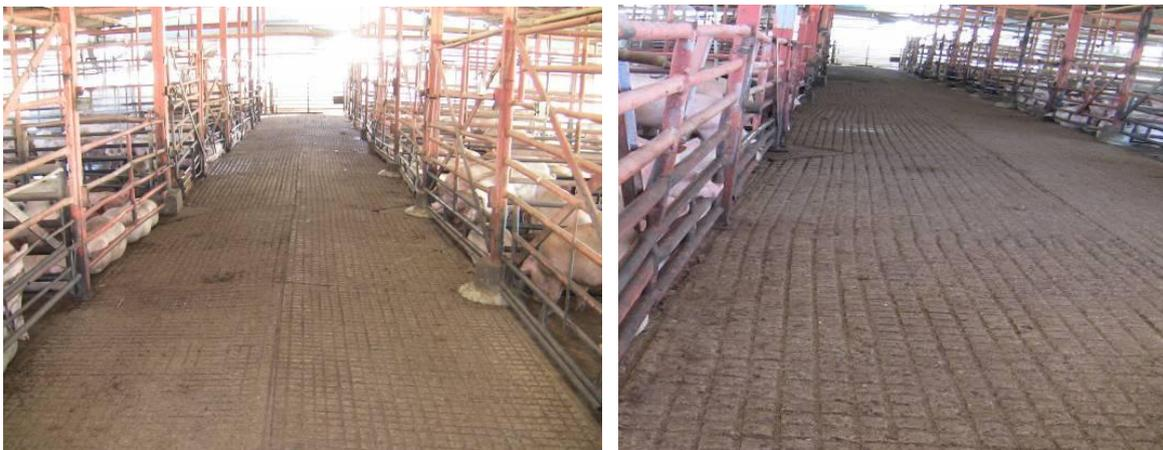
Fotos 4 y 5. Piso tipo cuadrículado de “hormigón”, disminuye incidencia de resbalones y caídas.
