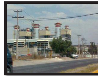
Subestación eléctrica de Tecámac.
