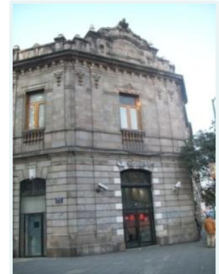
Gráfico No. 19. Edificio de la Cigarrera. Vista Norte.
