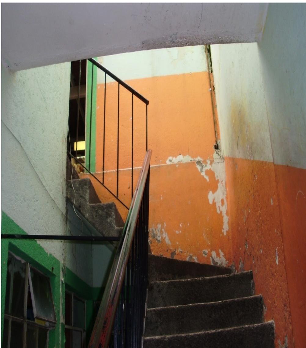
En la siguiente fotografía se muestra un fragmento del techo tapado con lámina, por donde se cuela el agua y se observa la presencia de humedad en la pared.
