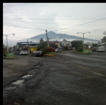
Parte de la problemática es el mal estado de la capa asfáltica, la irregularidad de las secciones viales, y la falta de señalizaciones.
