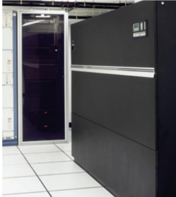
Figura 2.13: Equipo de climatización de Precisión.
