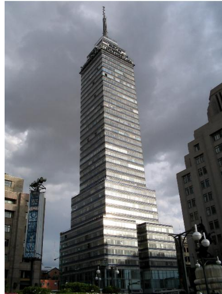
Fig. 112 Torre Latinoamericana (Construida entre 1946 y 1956) México, DF
