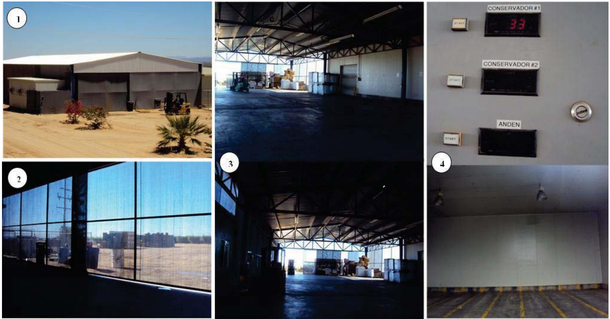
Fig. 17. Almacén: 1) Vista externa, 2) Malla delimitante, 3) Vista interna y 4) Conservador. 1
