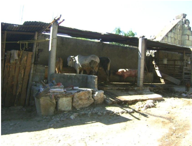
Fig. 5.3. Ocupación de la hacienda Alemán. Un establo y chiquero en lo que fuera la casa grande. La mampostería que aún se conserva presenta una excelente calidad en su ejecución. Foto: A. H. Enero 2011.
