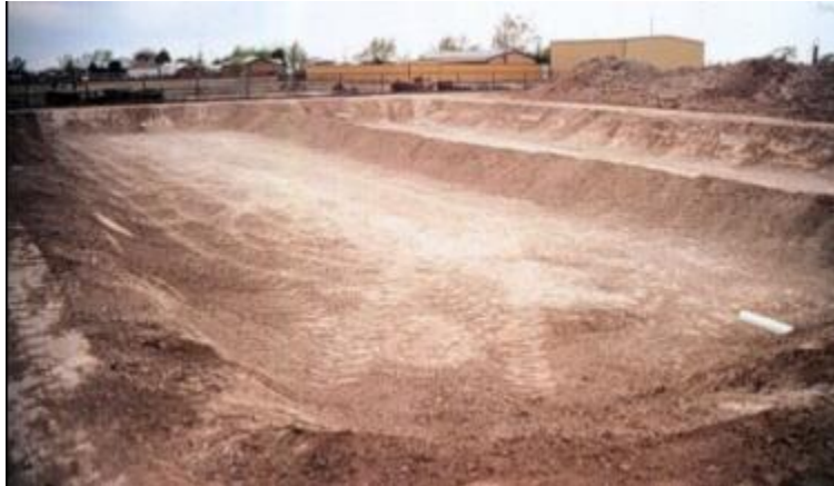
ILUSTRACIÓN 15. UN SITIO EXCAVADO Y GRADUADO QUE MUESTRA UNA CUESTA LEVE (~1%) EN LA DIRECCIÓN.
