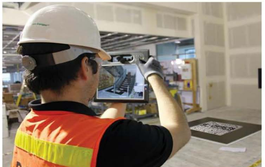
Arriba: Concepto de una posible aplicación de la Realidad Aumentada dentro de una obra en construcción, con la cual es posible visualizar elementos que componen el proyecto de una manera distinta.
