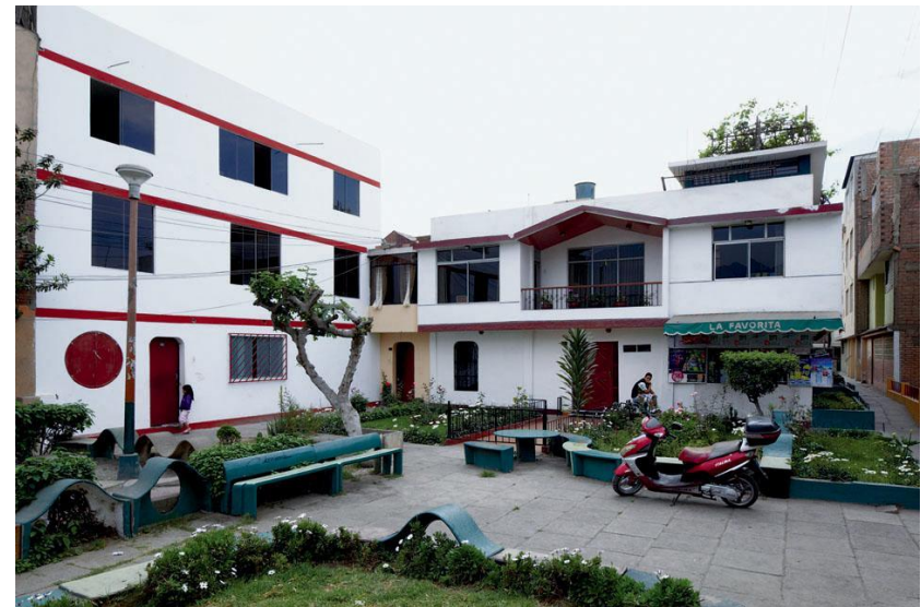
Fig. 14 Estado actual de plazoleta mostrando el crecimiento orgánico de las viviendas e inserción de tienda de conveniencia barrial.
