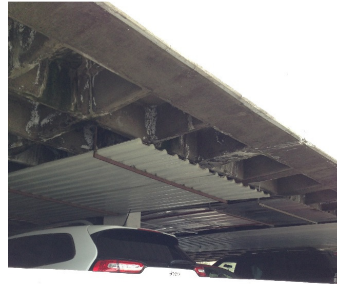
Fig. 73 Fotografía propia; Visita al Sitio, 2014.
