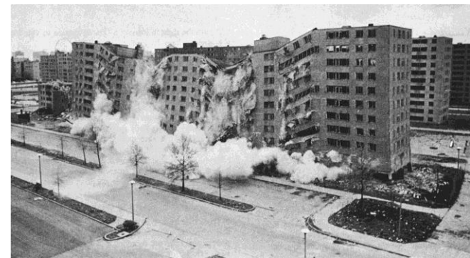
Fig. 3 Demolición de Pruitt Igoe, Minoru Yamasaki
