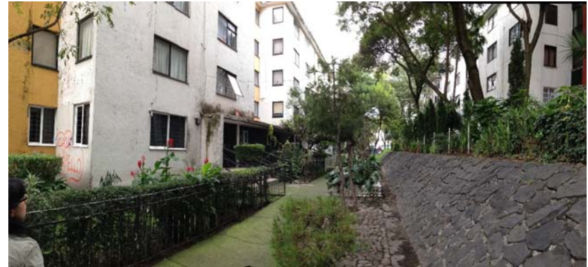
Fig. 62 Fotografía propia; Visita al Sitio, 2014.
