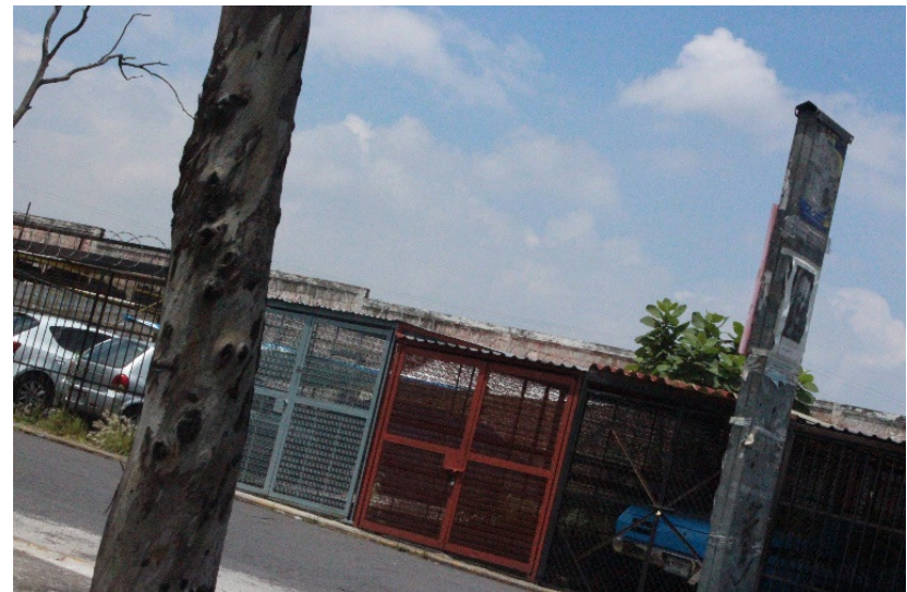
Fig. 59 Fotografía propia; Visita al Sitio, 2014.
