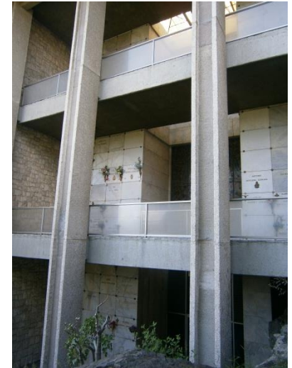
Fachada trasera del edificio
