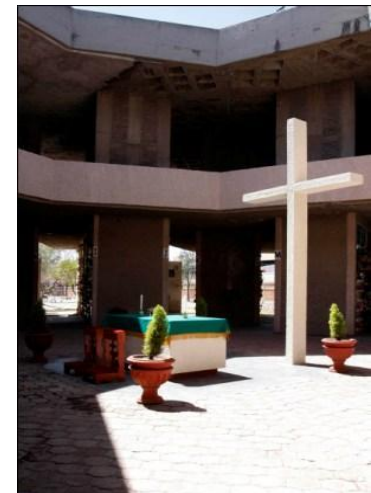
Imagen.- Área de nichos Núcleo de nichos, formado por un solo edificio, con patio central
