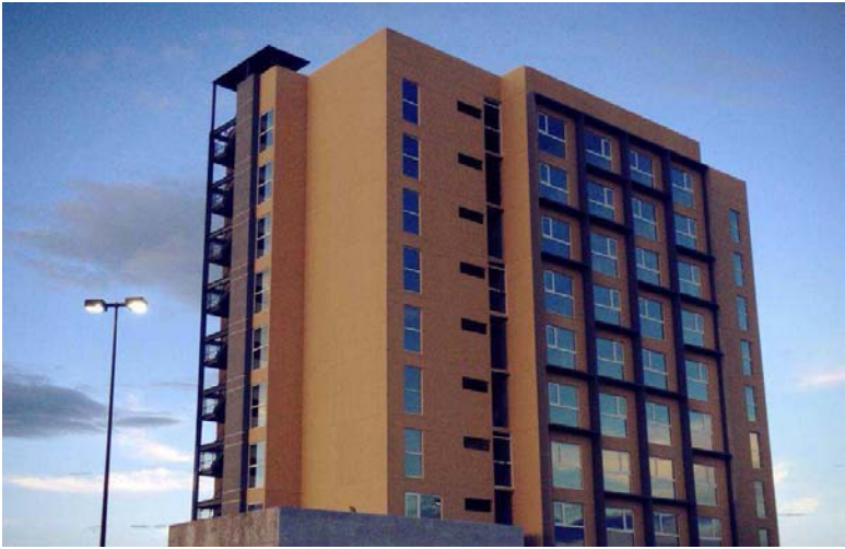
Segundo Hotel en Celaya: Casa Inn Galerías.
