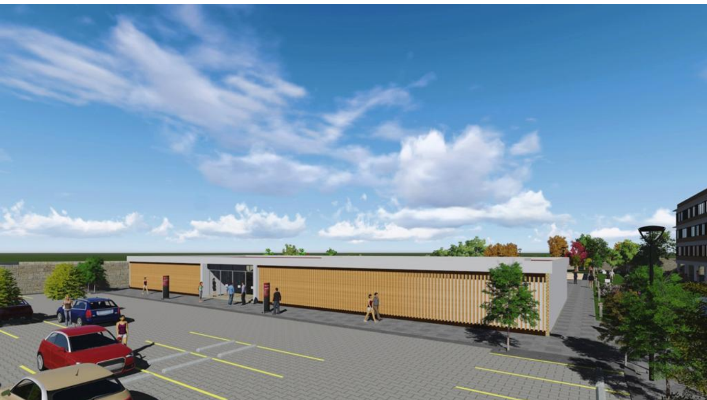
VISTA DEL EDIFICIO DE ADMINISTRACIÓN
