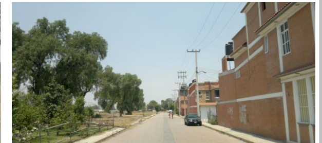
FOTO 4 Vista de la calle Zapata Vive hacia el Poniente
