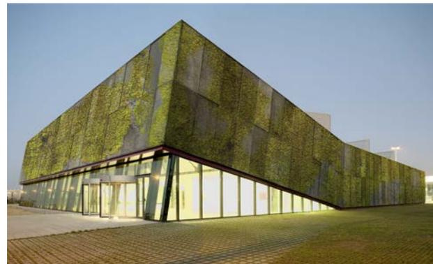
Imagen 36: Simulación de una fachada vegetal en el Centro Cultural Aeronáutico del Prat de Llogregat. Fuente: UPC.
