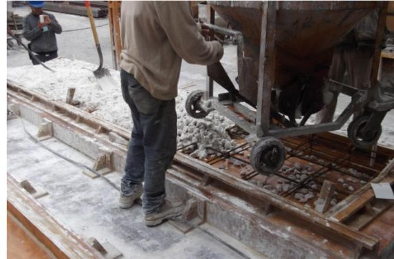
Imagen 60: Vaciado del concreto para el prefabricado.
