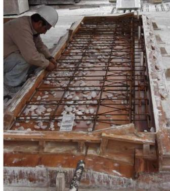
Imagen 59: Colocación del armado de acero.
