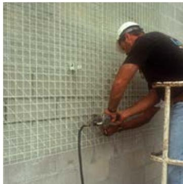
Imagen 47: Sistema para plantas trepadoras, se muestra la estructura donde se dispersarán éstas.
