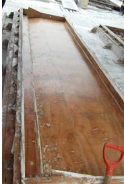
Imagen 58: Molde de madera para el prefabricado.
