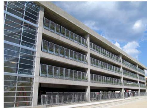
Imagen 48: Sistema G-Sky, producto tipo Basic Wall, compuesto de una caja donde se inserta la planta trepadora.
