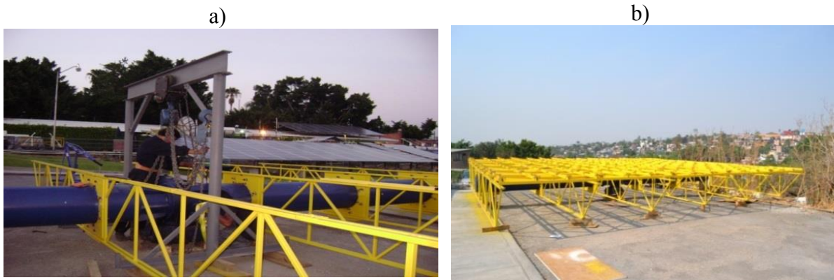
Figura A2. En la imagen a) se presentan los brazos y las costillas niveladas y en la b) se muestran además los marcos nivelados.
