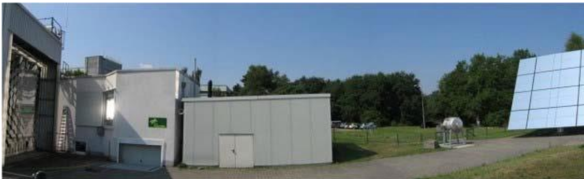
Fig. 1.14. Instalaciones del horno solar de Colonia, Alemania. De izquierda a derecha se observa: el concentrador, el laboratorio donde se encuentra el punto focal y el helióstato.
