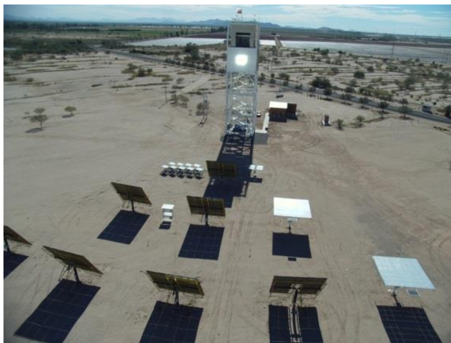
Figura 1.7. Imagen de la planta de torre central CPH.
