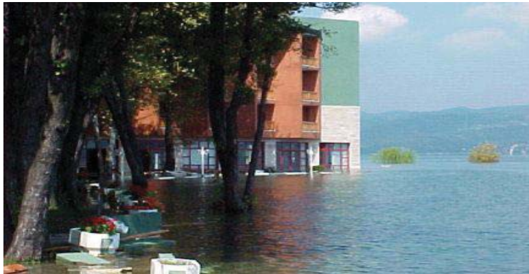
Figura 1.3. Hundimiento del hotel bajo condiciones finales de licuación (Aydan et al. , 2004).
