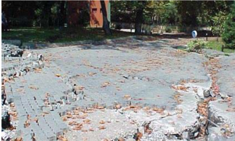
Figura 1.2. Desplazamientos laterales observados en el estacionamiento del Hotel Sapanca (Aydan et al. , 2004).
