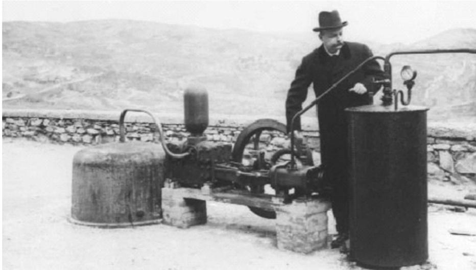
Fig. 1 Primer sistema de generación eléctrica con geotermia [3].
