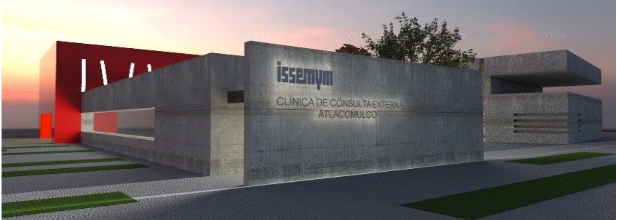
Vista atardecer de la Fachada Lateral Suroeste.
