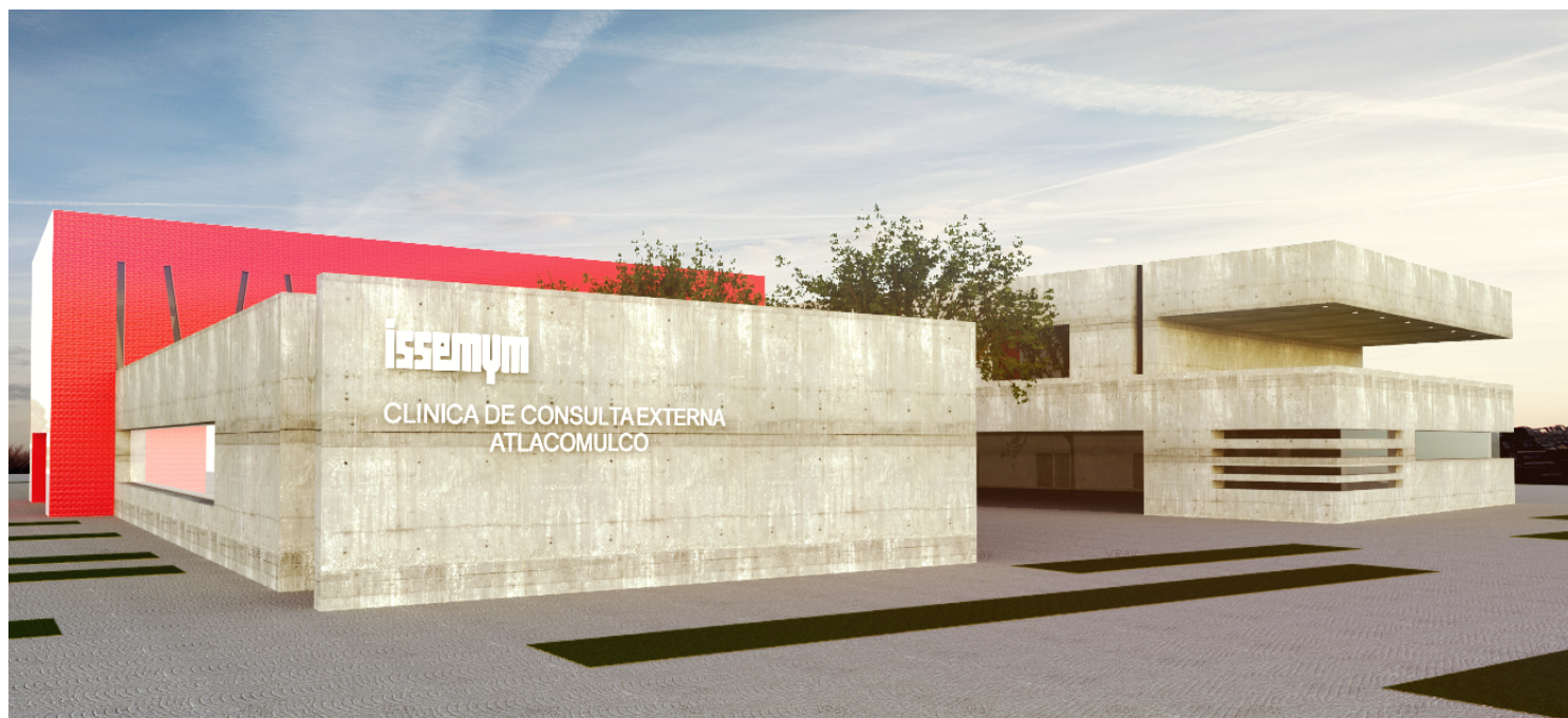
Vista hacia la Fachada Lateral Suroeste y Acceso a Farmacia.
