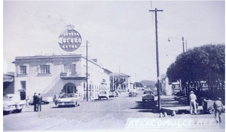
Foto: Calles con pavimento y alumbrado. Atlacomulco.
