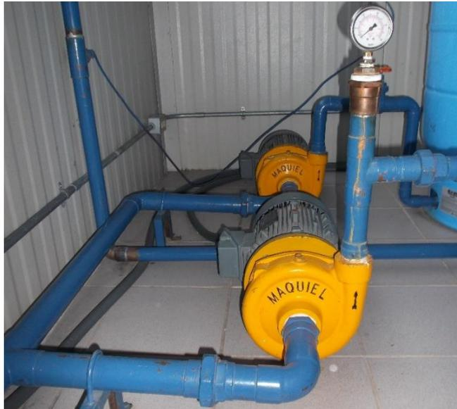
Ilustración 5.1 Equipo de bombeo para suministro de agua a mesa de laboratorio.
