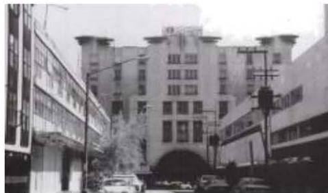
Edificio Ermita como parte del Mercado
