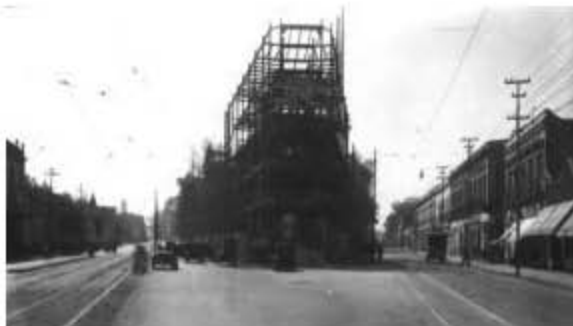
Fotografía de la demolición del Portal de los Mier. Fototeca Nacional. 1929
