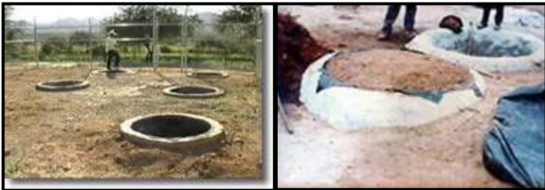
Fig. 33 Preparación de los pozos de tierra sellados para la Fermentación (Bebidas de Sonora, 2002)
