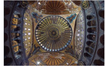
Fig. 35 Cúpula central interior Santa Sofía (encuentro de las cúpulas y vista de los cuatro triángulos)
