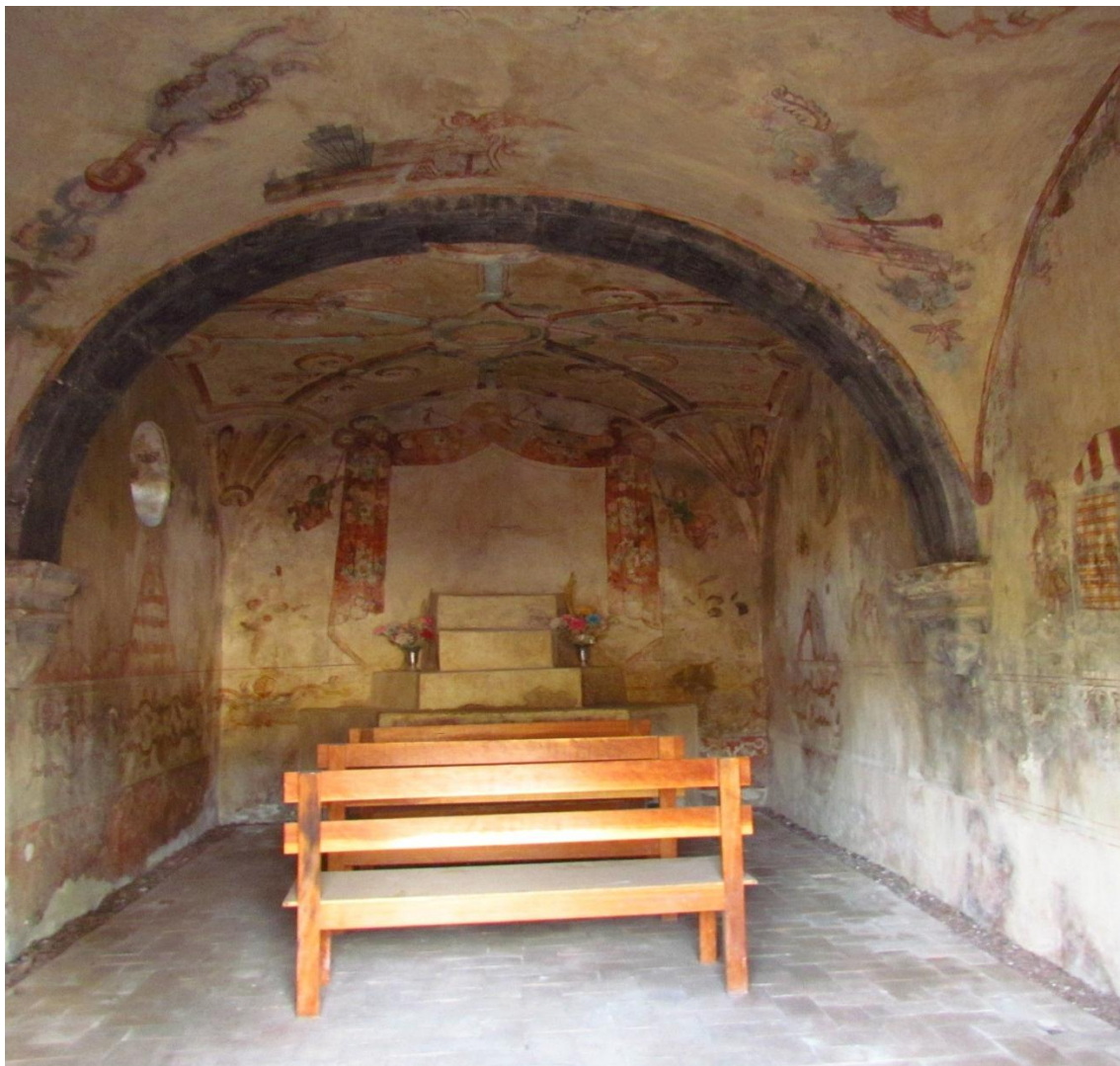
Imagen 14. Vista general del interior, desde el vano de acceso. Capilla La Pinta. San Miguel Ixtla. Foto BIPP.
