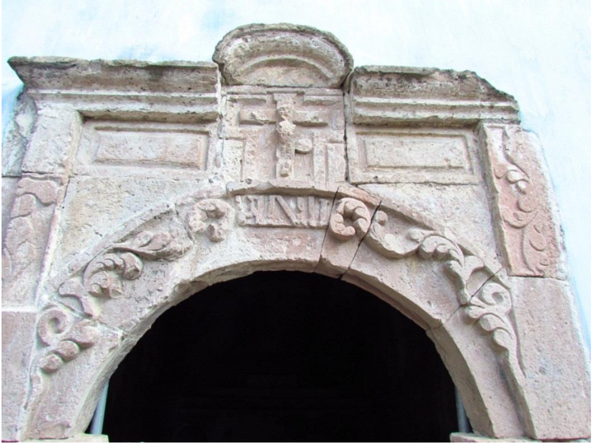
Imagen 48. Arco de entrada, detalles de la cantera labrada. Capilla de Los Ángeles. San Miguel Ixtla. Foto BIPP.
