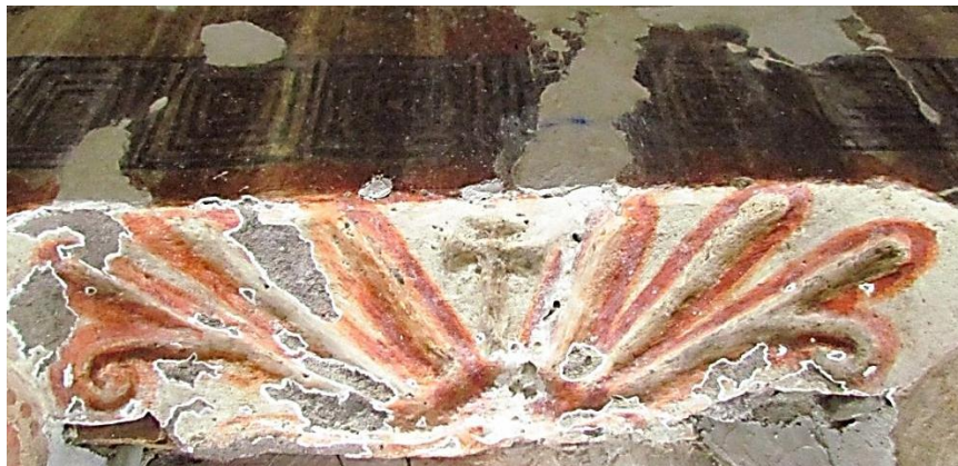
Imagen 63. Capialzado con venera bícroma, en el abocinado de la puerta. Detalle del Arco. Capilla de Los Ángeles. San Miguel Ixtla. Foto BIPP.
