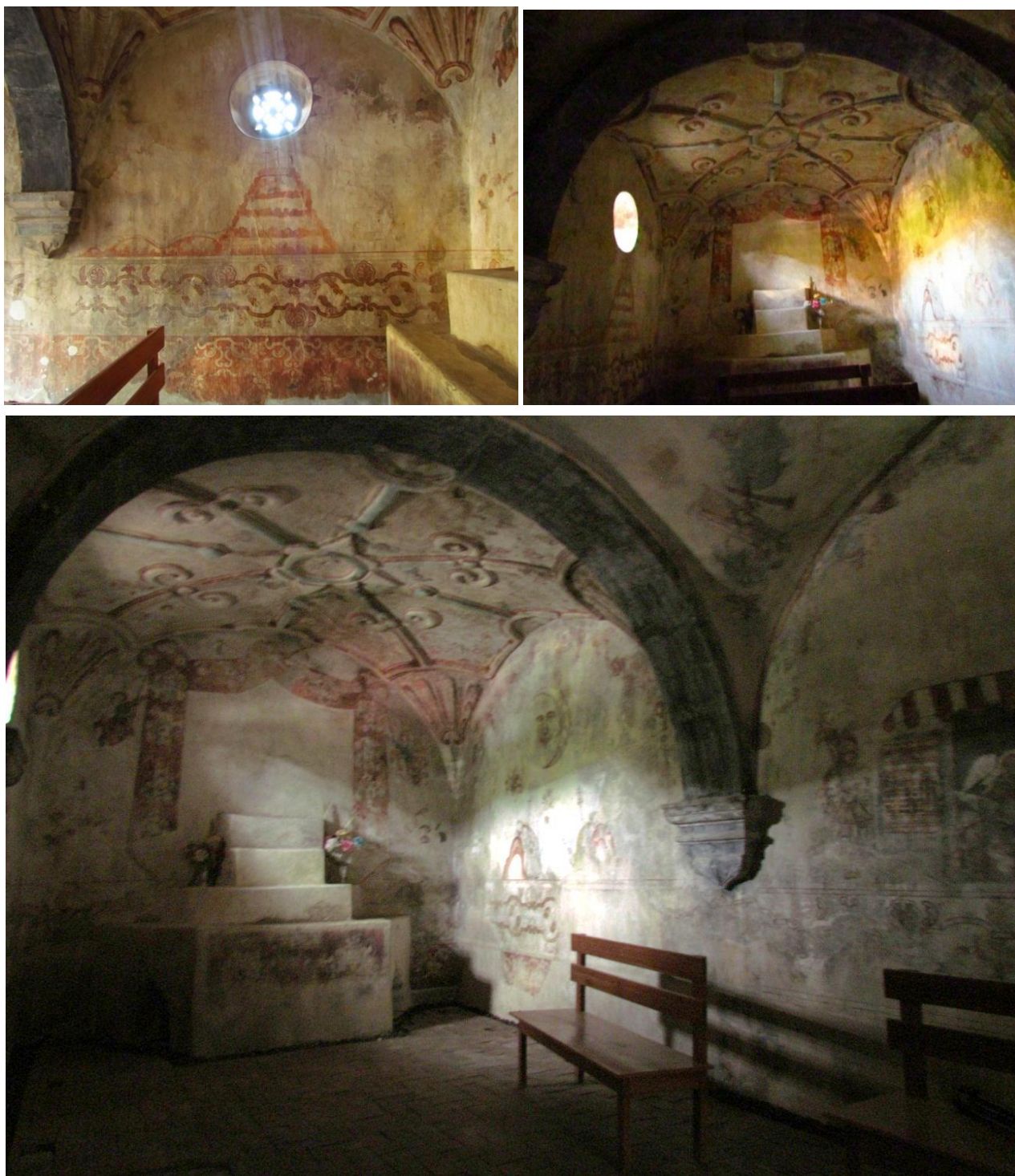
Imagen 46. Entrada de luz a la capilla. Capilla La Pinta. San Miguel Ixtla. Fotos BIPP.
