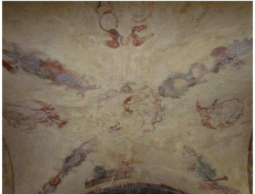
Imagen 34. Bóveda con ángeles músicos e instrumentos musicales. Bóveda cercana a la puerta, Capilla La Pinta. San Miguel Ixtla. Foto BIPP.
