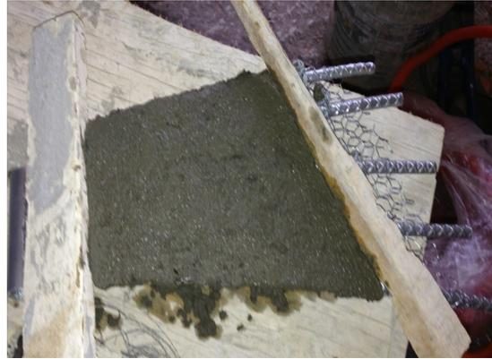
LA SIGUIENTE IMAGEN MUESTRA EL CONCRETO YA SECO. CON EL PESPEADOR DESEADO GRACIAS A LA FORMA DE COLOCACIÓN DEL CONCRETO.
