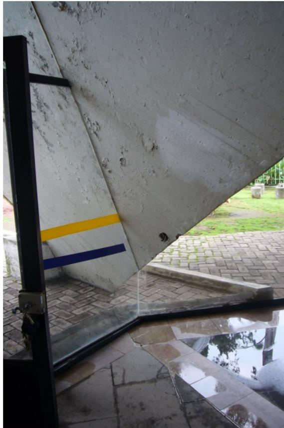
FIGURA 34. Apoyo de arranque del paraboloides
