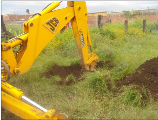
Fotografía 6.3. Ubicación de sondeos Fuente: Propia.
