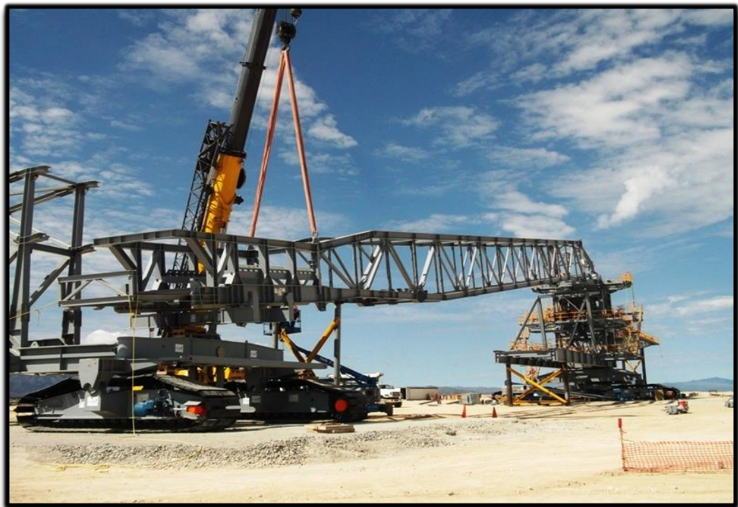
Figura 23. Estructura de las bandas del spreader.
