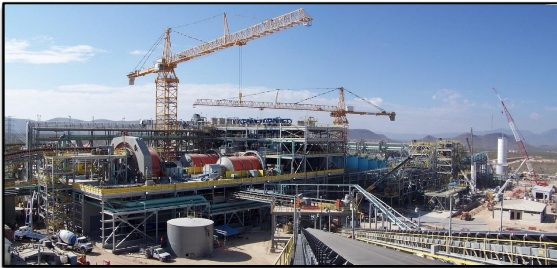
Figura 13. Área de proceso para la extracción del material.
