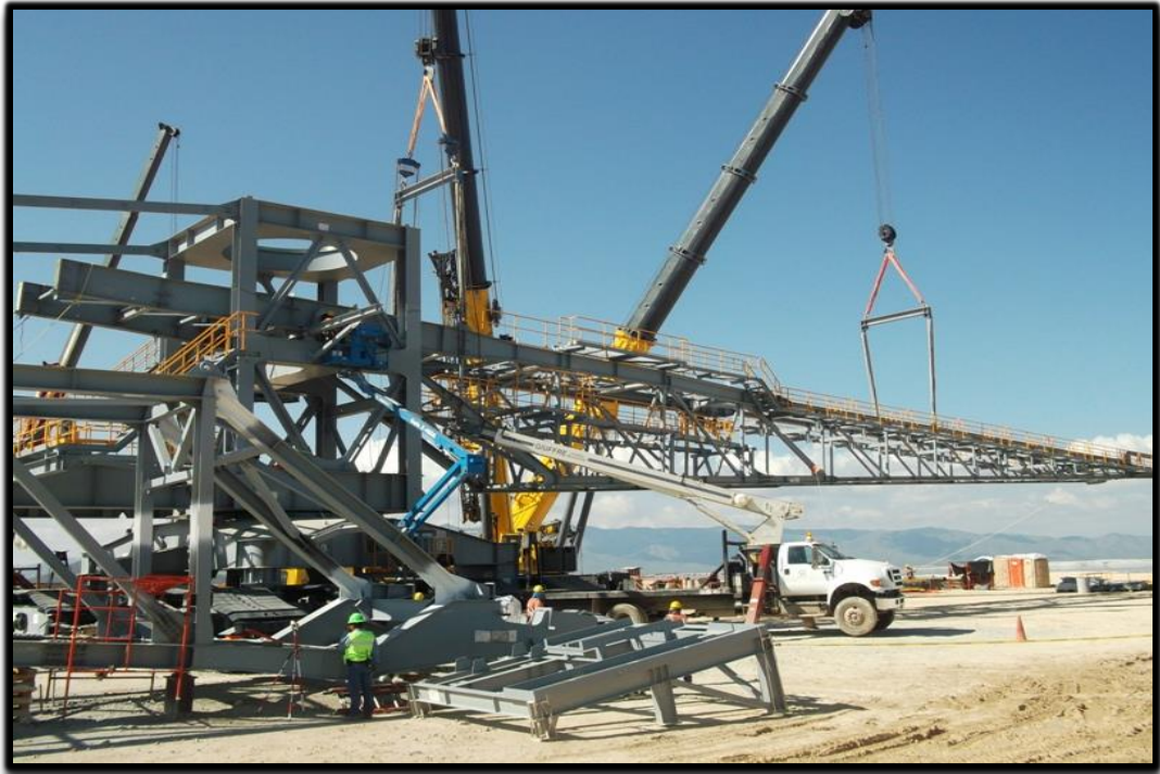
Figura 22. Montaje de la estructura de las bandas del spreader.
