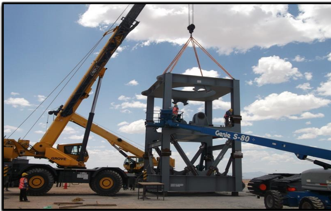
Figura 21. Montaje de la estructura central del spreader.
