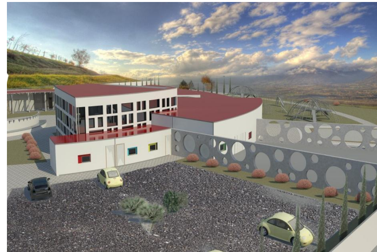
Vista Norte Estacionamiento
