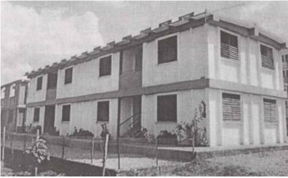
Imagen 15. Viviendas de uno y dos pisos en ferrocemento. [Naaman, 2000]
