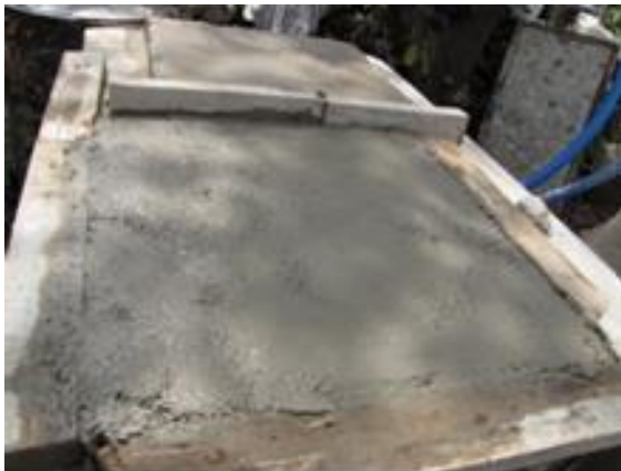
Imagen 14. Colado del Panel 1 y 2, se les coloco un marco provisional de madera el cual se retiró a las 2hr de finalizado el colado con la finalidad de mantener las dimensiones de 59.5x59.5cm.
