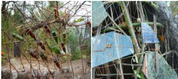
Imagen 8. Ferrocemento con barro y varas de bambú, estructura.
