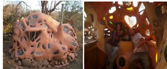
Imagen 9. Ferrocemento con barro y varas de bambú, estructura.
