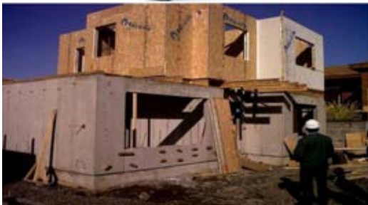
Cementos BioBlo Innovación regional en sistemas constructivos. Ferrocemento.
