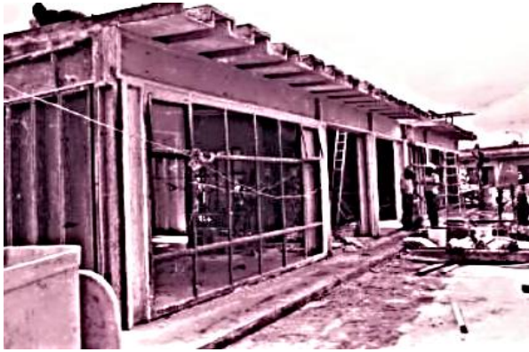
Imagen 13. . 1960's Primera casa experimental de Ferrocemento. 36mts 2 . Tiene dos recamaras, estancia, baño y cocina. Los muros se construyeron con tableros de 1 mts de ancho, nervaduras y tímpanos de 15cms, espesor de losa de 2.5cm. Techo y muro se armó con una retícula de alambrión de ¼" de diámetro y 3 capas de malla hexagonal cal. 22 de abertura de 1". Fuente: Alfonso Olvera
