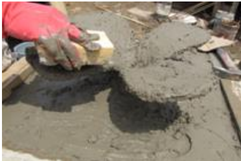
Imagen 21. Detallado del colado realizado 2hr después de colar la base
