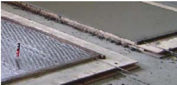
Imagen 7. Sección típica de ferrocemento. [Bedoya, 2003]
