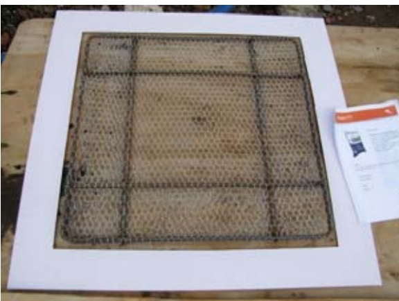
Imagen 12. Ilustra el armado y enmallado de los Paneles 0, 1, 2 y 4
