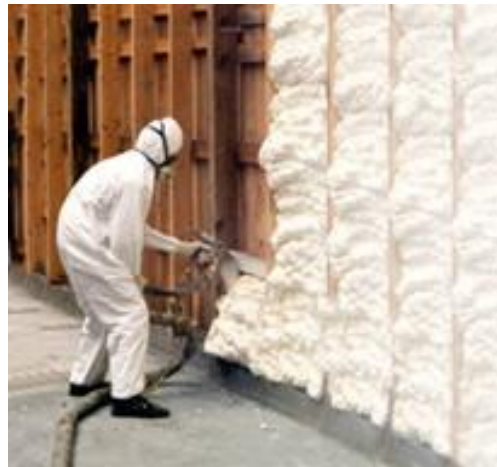
Imagen 30. Aplicación de la espuma. Fuente. http://www.empresasalcantar.com/servicios.htm
