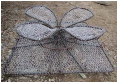
Imagen 20. Armado para el Panel 4 Ferrocemento Verde
