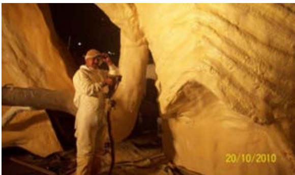
Imagen 32. Aplicación de espuma de poliuretano. Fuente: http://ecatepecdemorelos.olx.com.mx/impermeabilizaciones-termicas-en-un-dia-para-muchos-ano-aislapol-57706475-iiid-419655454
