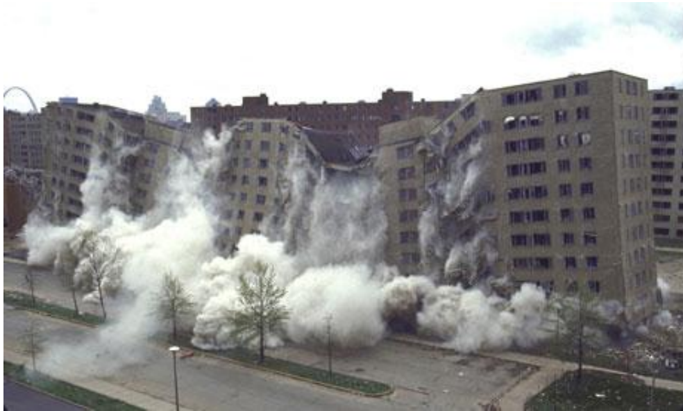
112. Pruitt-Igoe, parte del conjunto en demolición, 21 abril 1972.
