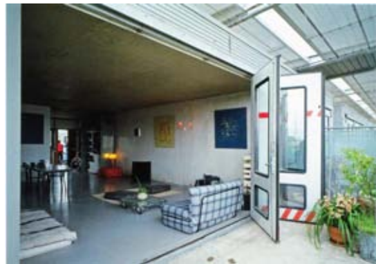
27. Puertas plegables de garaje permiten unir el espacio interior con el exterior. Fuente: (Jodidio, 2012:35)
