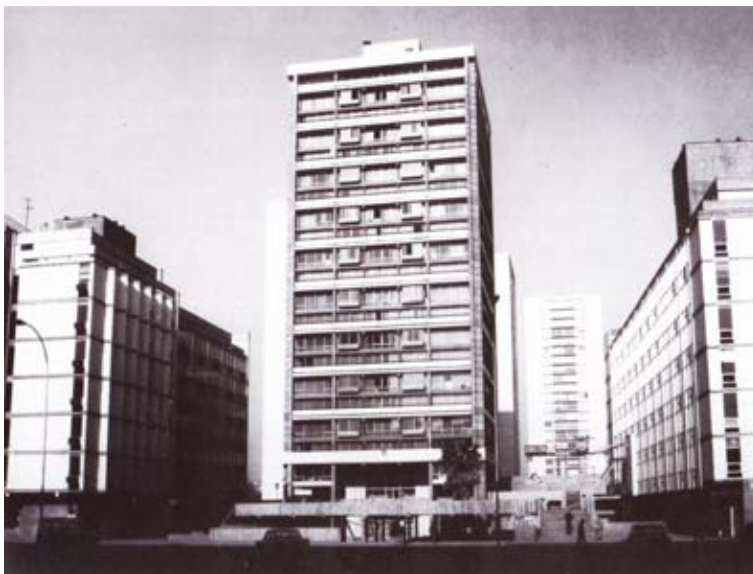
72. Modulación en la fachada donde se refleja la diferenciación de las áreas sociales y privadas que se tienen al interior de la vivienda. Fuente: (Pérez, 2006:125)
