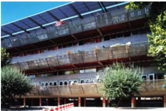
26. El edificio flota sobre pilotes. Fuente: (Jodidio, 2012:34)
