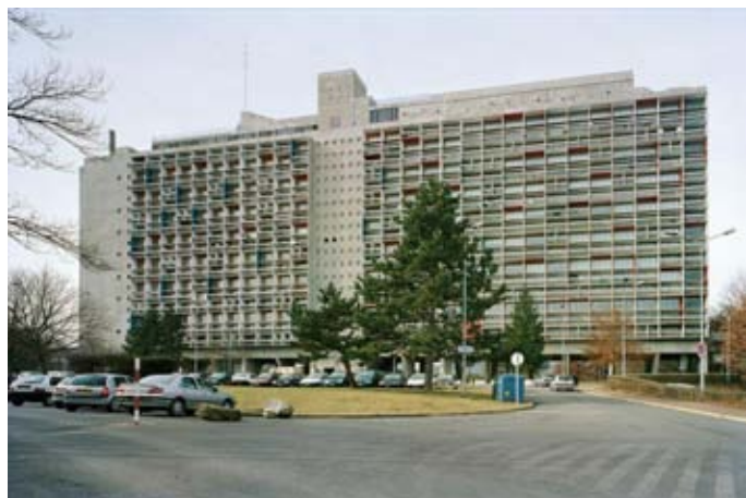
10. Unidad Habitacional Firminy, Francia (1960). Fuente: http://www.fondationlecorbusier.fr
