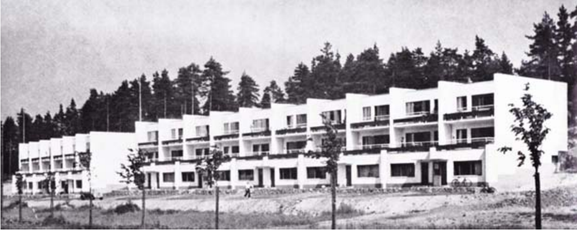
128. Casas en serie. Cada unidad comprende tres viviendas con entradas y escaleras independientes dado que se utiliza la pendiente. Fuente: (Aalto, V.1, 1995: 100)
