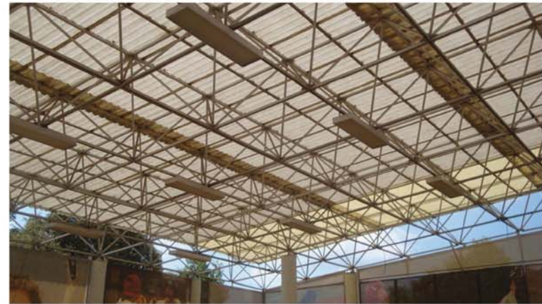
Cubierta tridimensional con acrílico y espacios laterales para evitar la acumulación de calor
