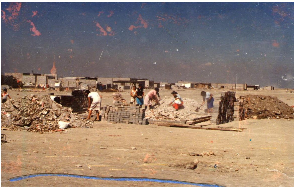
Foto tomada en Septiembre de 1988. Construcción del futuro primer salón de clases de la Escuela Secundaria Oficial No. 0515 Josefa Ortiz de Domínguez 155
