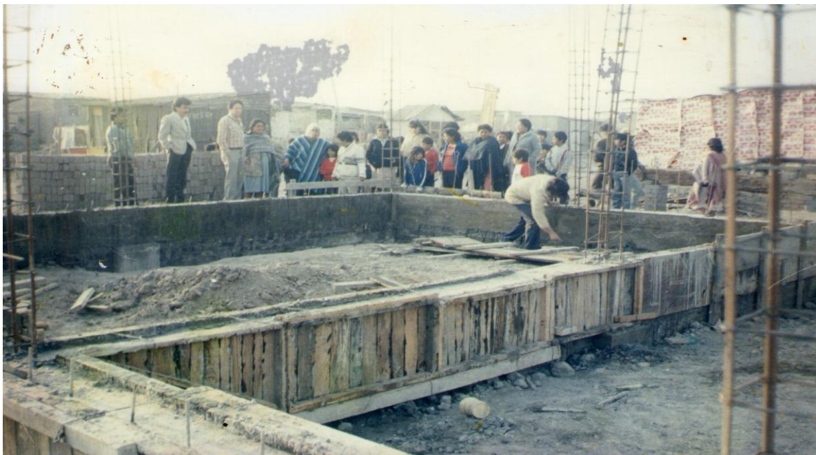
Foto tomada en enero de 1989 164 . Construcción de los cimientos de la Escuela Secundaria oficial No. 0515 Josefa Ortiz de Domínguez
