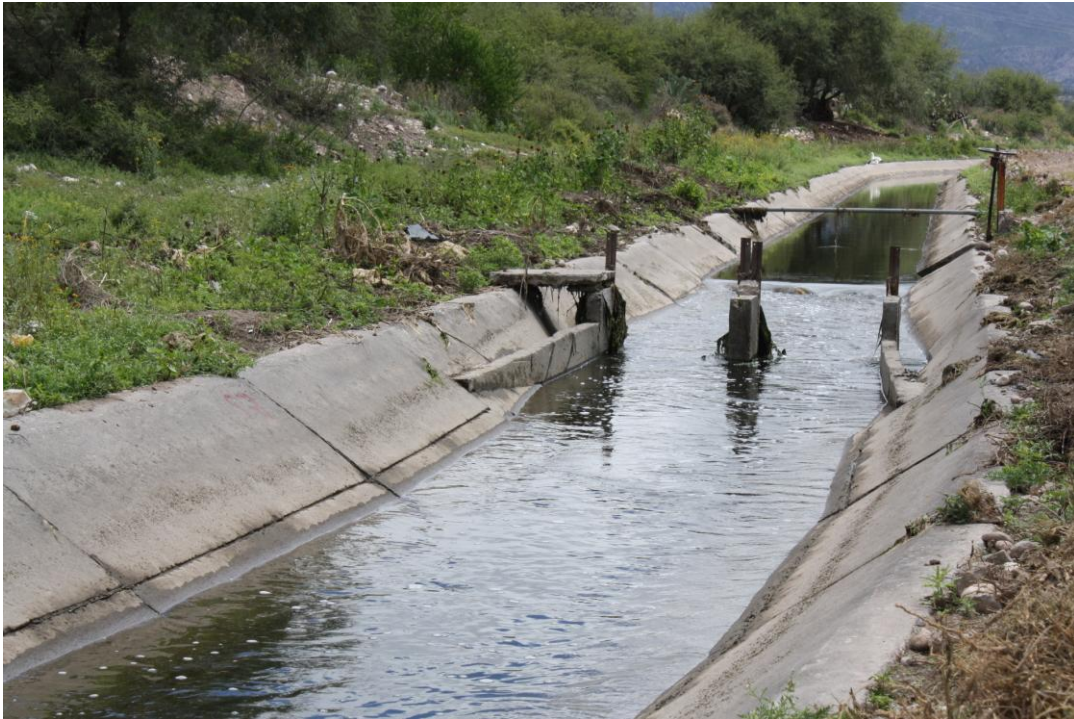
Canal de riego aguas negras, Cerritos Ixmiquilpan , Archivo personal (febrero, 2014)
