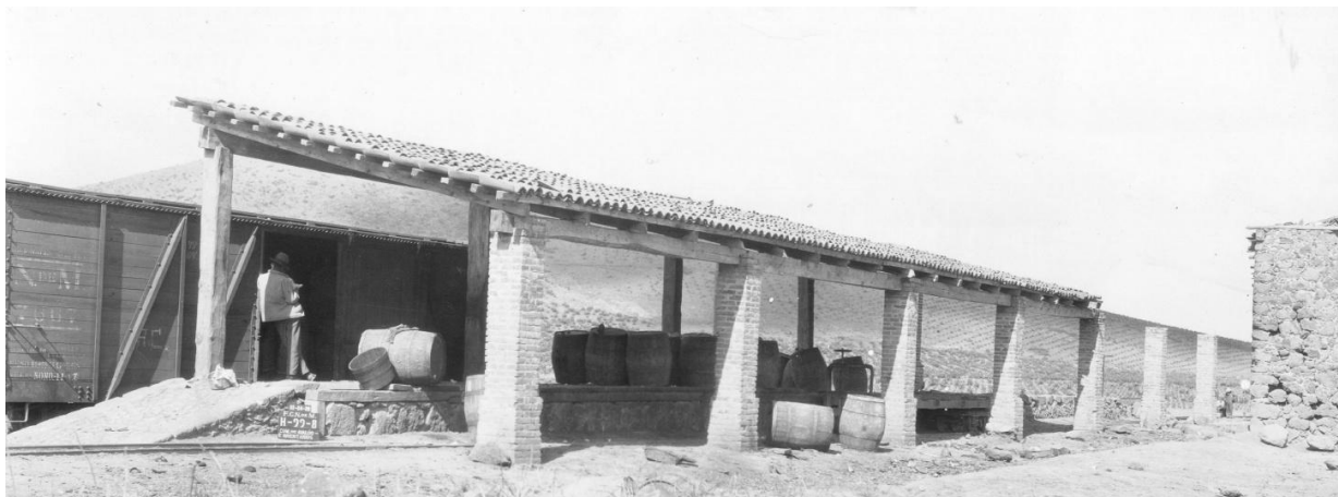
Anden de embarque de pulque de la estación de San Vicente, Hidalgo, Ferrocarril de Hidalgo y del Nordeste.
