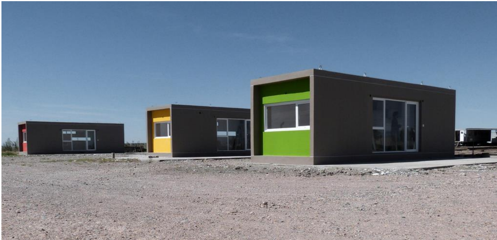
Img. 32 Viviendas de emergencia para madres solteras.
