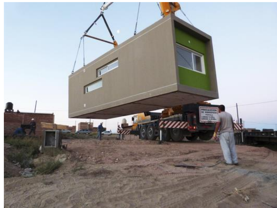
Img. 33 Desarrollo de la construcción de viviendas de emergencia.
