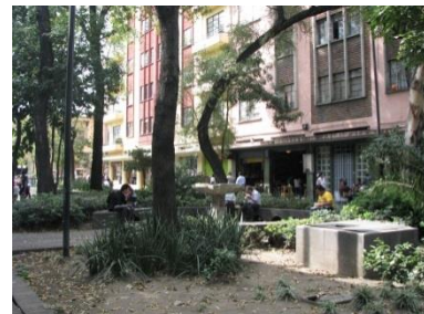
Área jardinada que muestra la falta de integración en el establecimiento de registros, además de la falta de mantenimiento a la vegetación arbustiva y parte del arbolado que se observa con más de 30° de inclinación.
