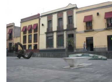
Área vestibular del Templo de San Jerónimo, donde se posiciona el mobiliario urbano que forma parte de la exposición temporal "Diálogo de Bancas", y al fondo las unidades habitacionales construidas como apoyo a las familias damnificadas a causa del terremoto ocurrido el 19 de Septiembre de 1985.
