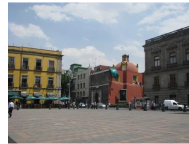
Vista sur-oriente de la Plaza Manuel Tolsá, donde se aprecia la armonía del conjunto arquitectónico (de izquierda a derecha: edificio de los Girasoles, Museo del Heroico Colegio Militar y parte del Palacio de Minería), en relación con el espacio de la plaza.
