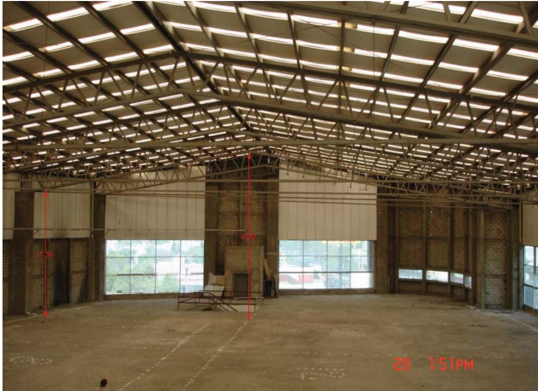
Fotografía 04 Vista de Local en su estado Original
