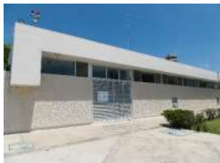
Imagen 22. Subestación Eléctrica Aeropuerto de Colima. 2013.
