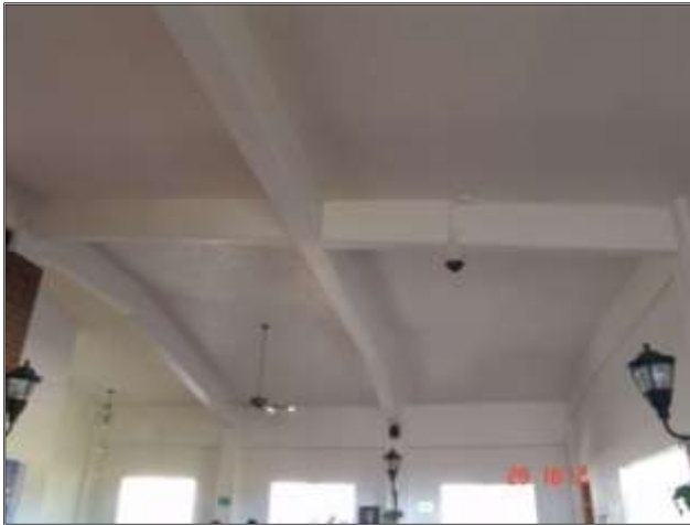
Imagen 77. Vista de losa en la sala de espera. ASA.2013.
