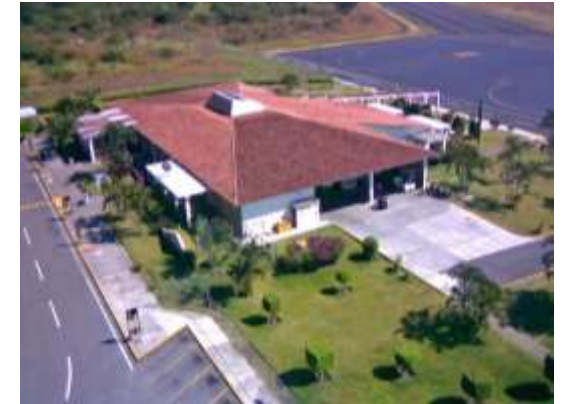
Imagen 70. Vista edificio de pasajeros. ASA. 2013
