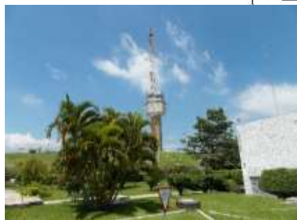
Imagen 23. Pararrayos en el Aeropuerto de Colima. 2013.
