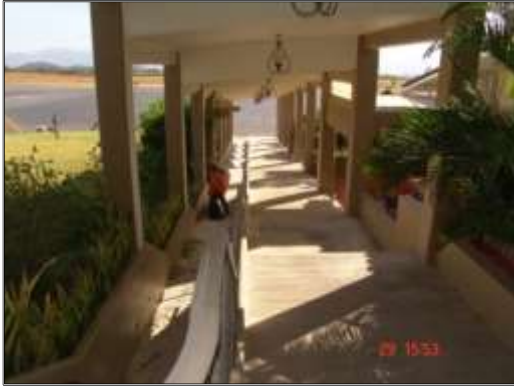
Imagen.74. Vista de la rampa y las escaleras de arriba. ASA 2013.
