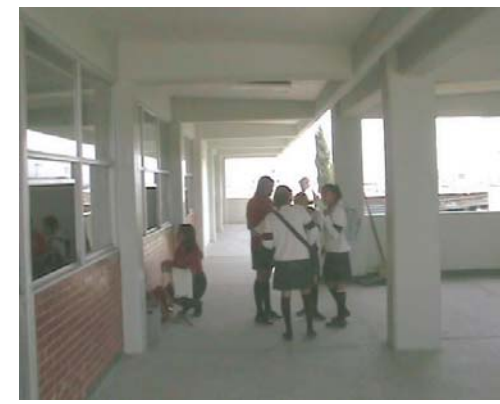
Imagen 42. Elementos estructurales y acabados
