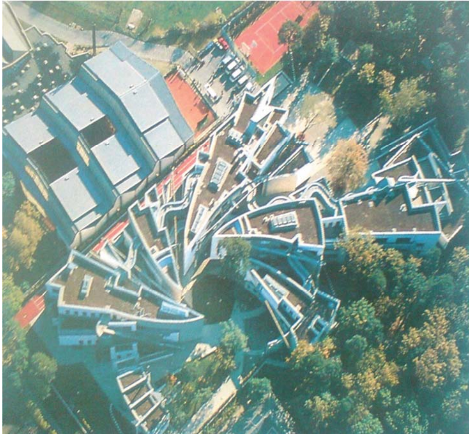
Imagen 49. Vista aérea, planta.
