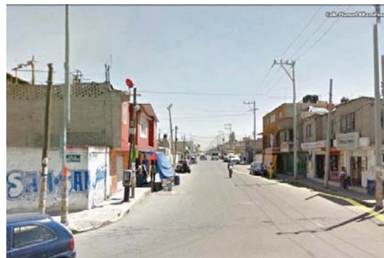
Imagen 22. Líneas de energía eléctrica y telefonía.
