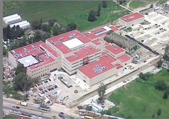
Imagen obtenida del sitio http://www.banobras.gob.mx/casodeexito/PublishingImages/Hospita-Regional-de-Alta-Especialidad-Ixtapaluca-(concluido)med.jpg
